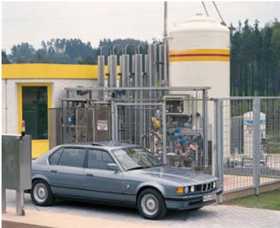
Obr. 18: Čerpací stanice vodíku pro pohon vozidel
